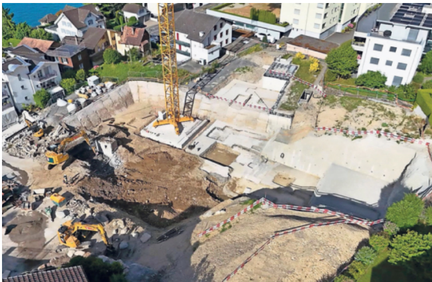
Die grosse Baustelle für den Neubau des Alters- und Pflegeheims Rosenpark in Gersau. Bild: zvg
