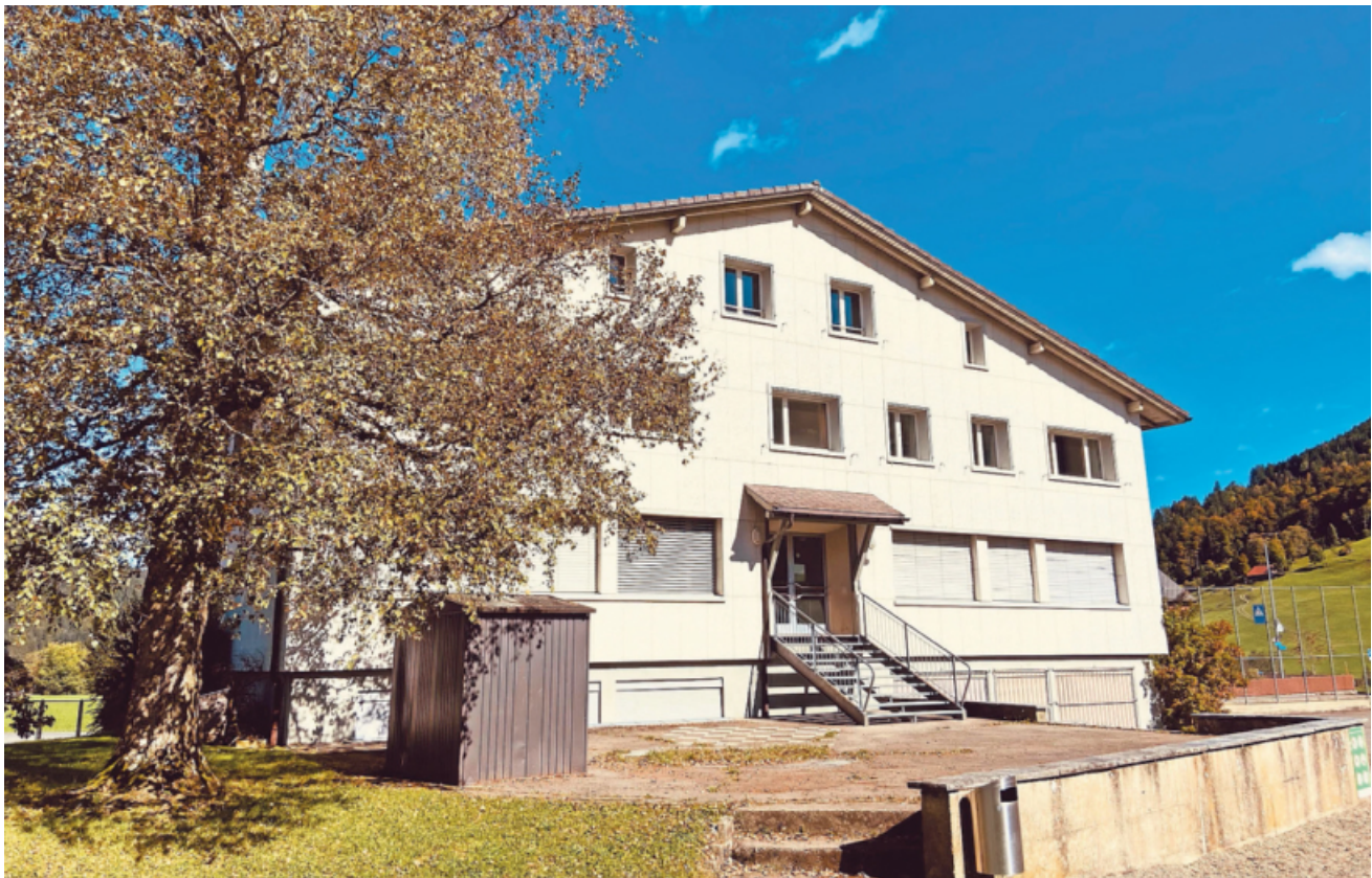
Das alte Schulhaus in Trachslau vor dem Umbau.
