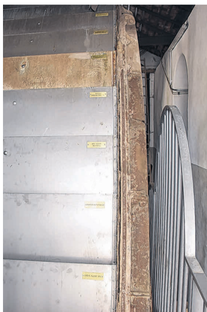
Die neuen Schaufeln sind angebracht.
